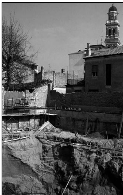
Fig. 5 - Stratigrafie sabbiose negli scassi del garage di via Brunetti presso la chiesa Rotonda (marzo 1994).
