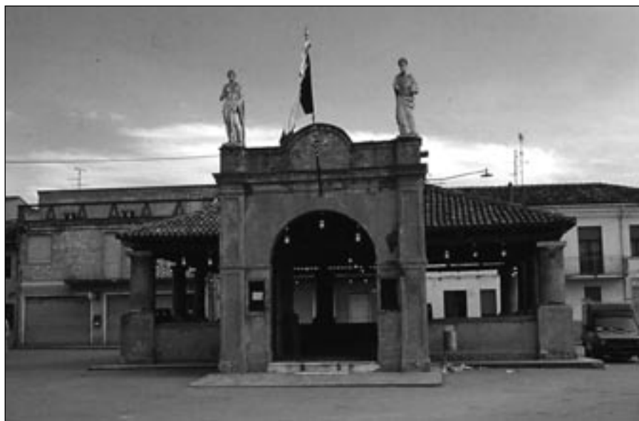
Il “Pavajon” prima del restauro.
